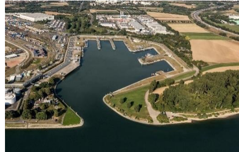
Quelle: BASF SE
